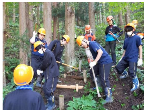
遊歩道の階段を補修
